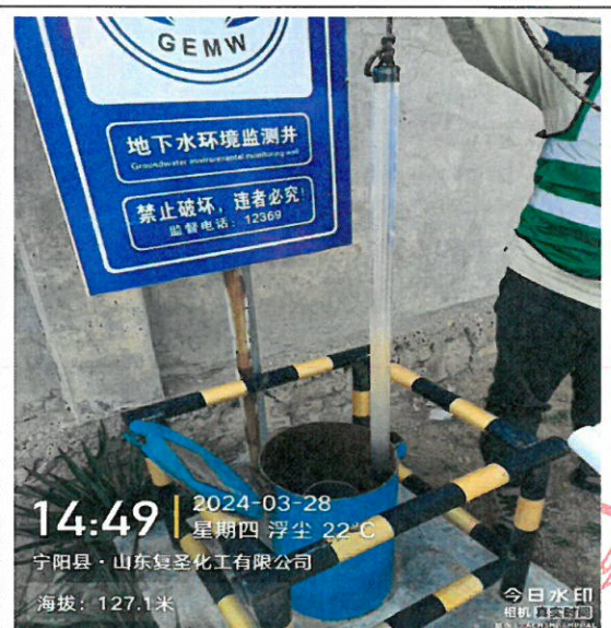
4#事故水池-消防水池-污水处理站区域
