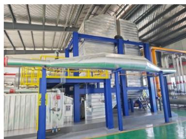
锅炉烟气 SCR 脱硝装置
